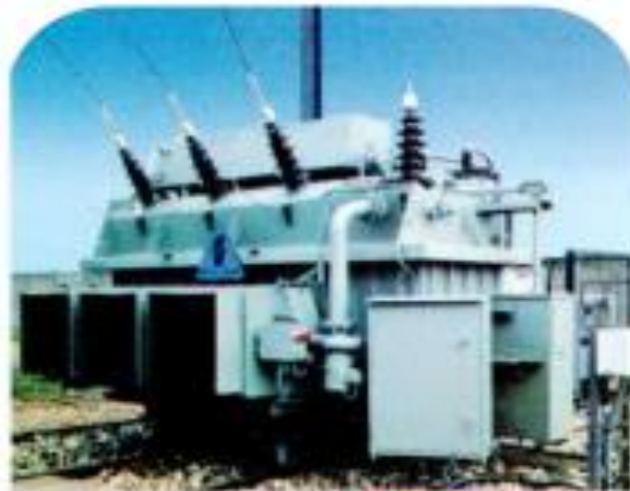
transformateur 25 MVA, 63/15 kV type "cloche" avec égale en charge, refroidissement type ODAF
