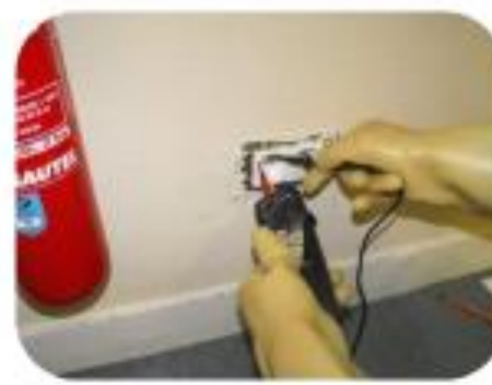
Vérifier l'absence de tension
