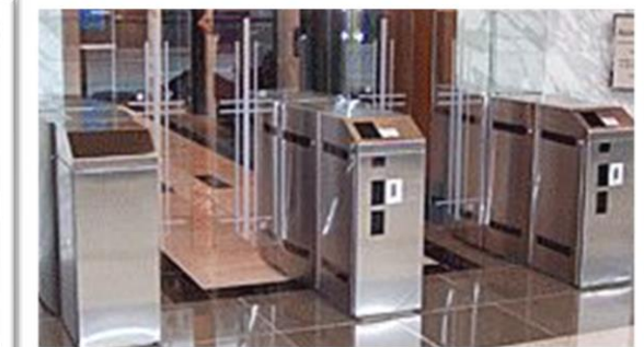
Couloir de contrôle
