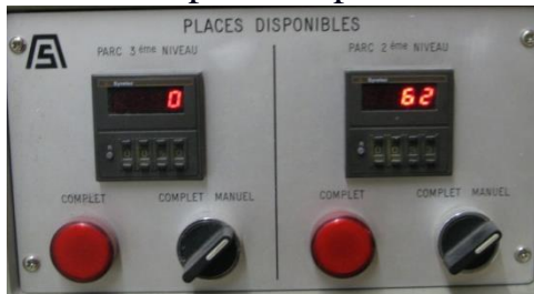
Parc de Stationnement couvert Compteur de places
